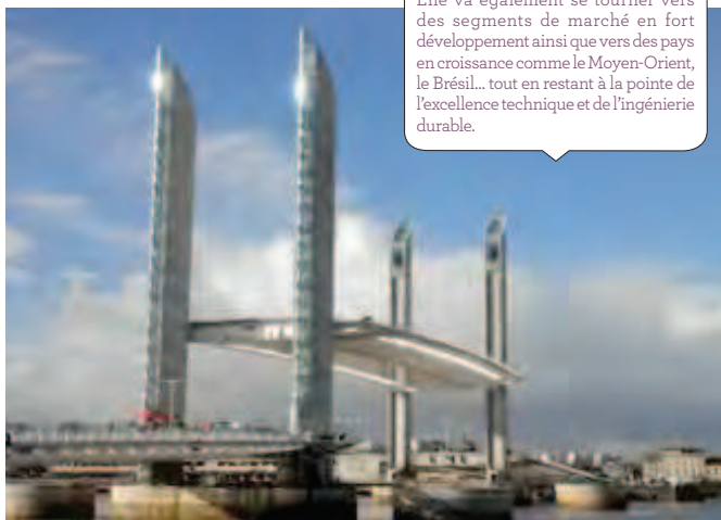
Pont Jacques Chaban-Delmas à Bordeaux, France
